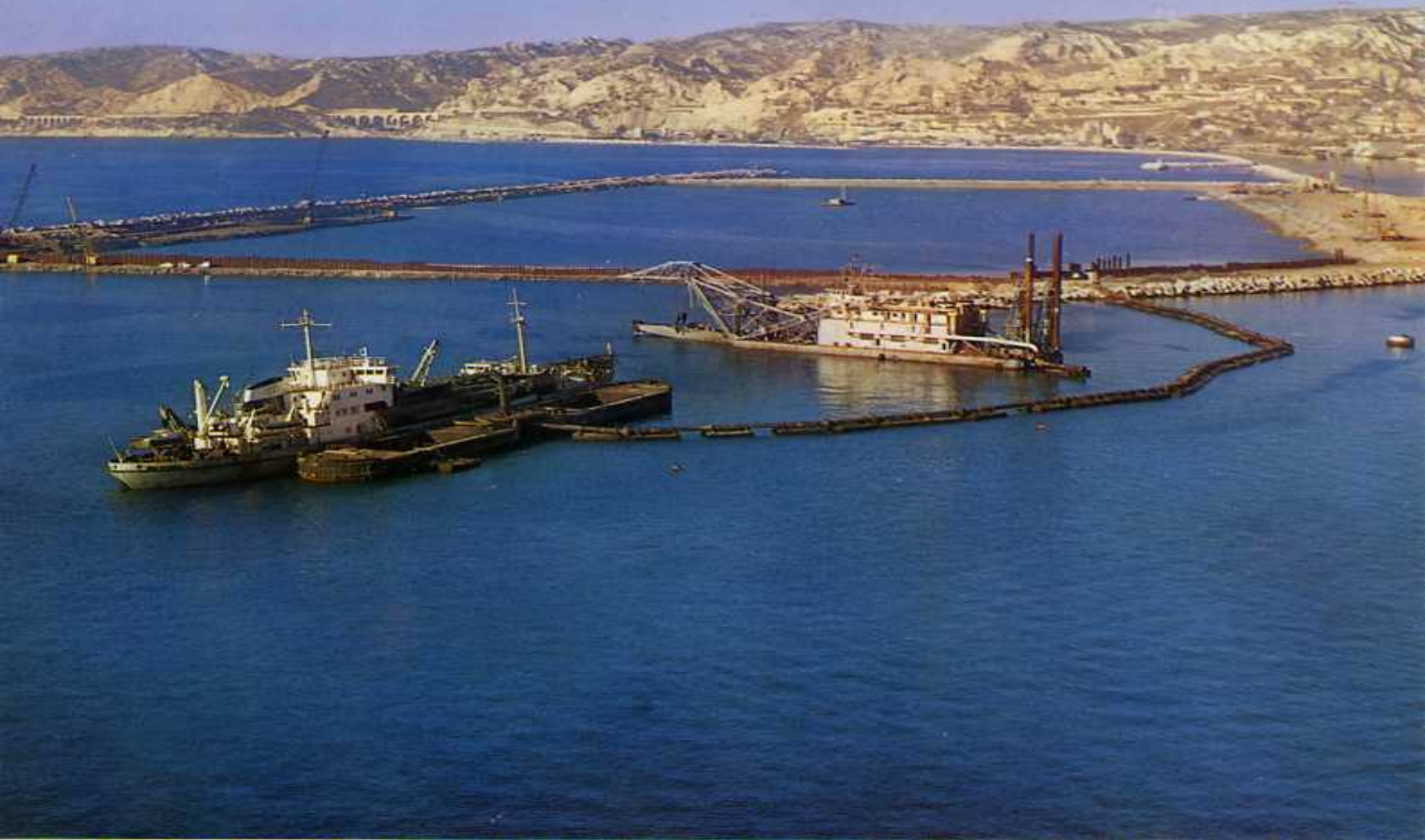
Marseille 1973. Refoulement d'une ceinture de sable pour la construction de la forme des 500 milles tonnes.
