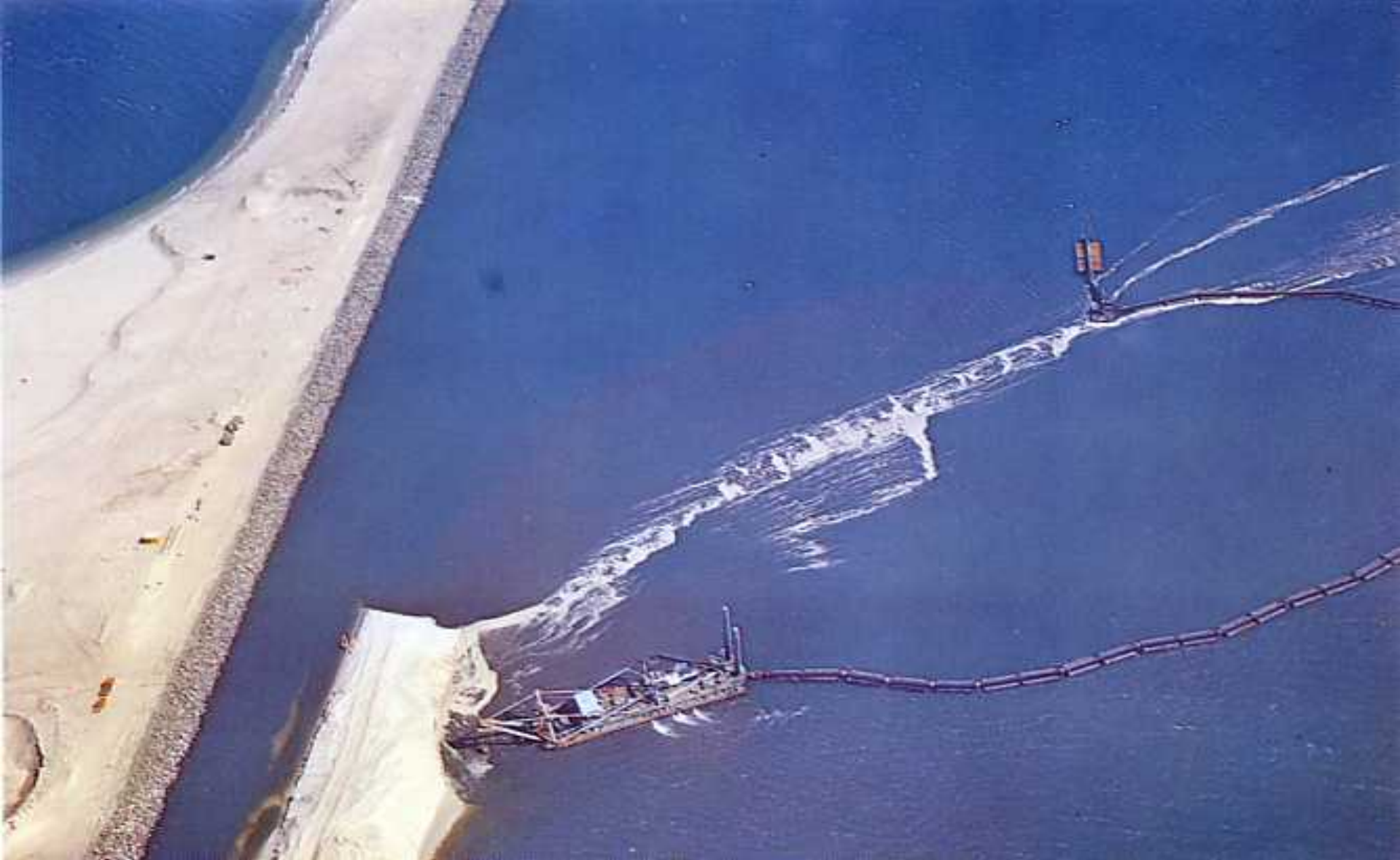
Aéroport de Sydney à Botany Bay 1970. La digue de protection est terminée, la drague à cutter drague la langue de sable ayant servi à assécher le fossé pour sa construction.
