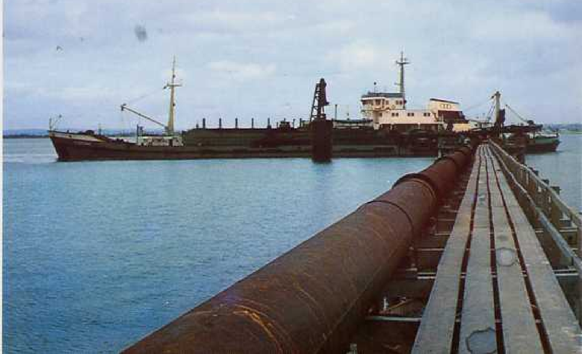
Aéroport de Sydney à Botany Bay 1970. La drague Atlantique vient refouler ses 4000 m 3 de sable sur le remblais de la nouvelle piste.
