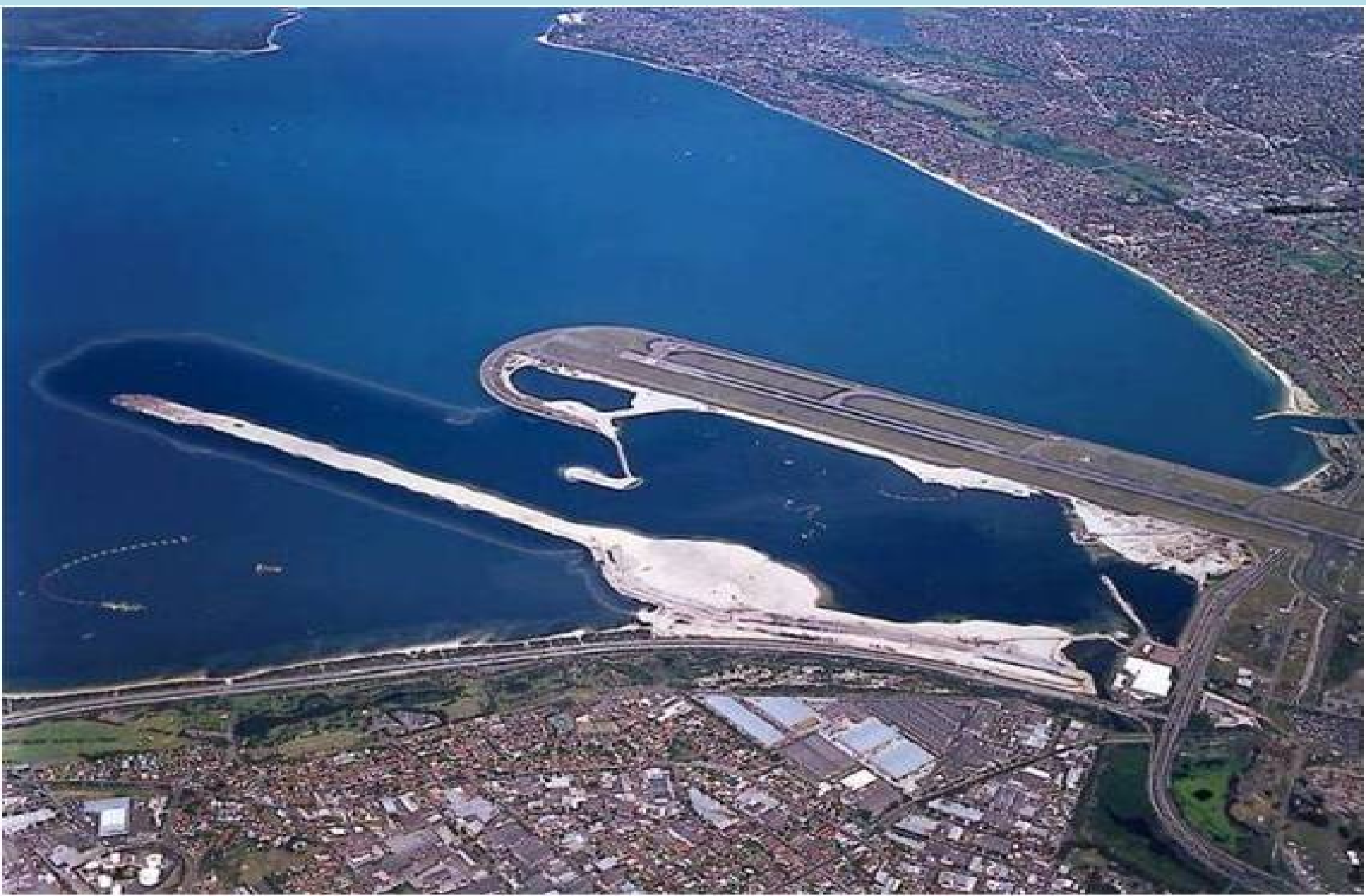
Aéroport de Sydney à Botany Bay en 1996 . Construction d'une deuxième piste
