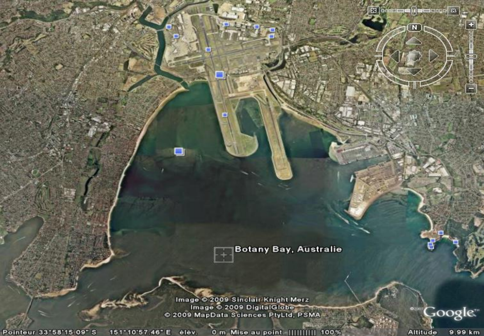
Aéroport de Sydney . Une vue de l'ensemble terminé en 2007
