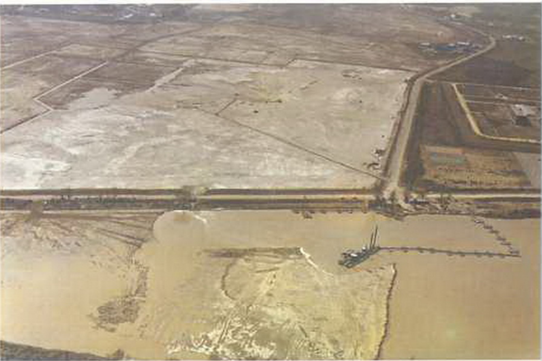
Blanquefort-FORD – Travaux de dragage et de refoulement en cours -1970-1971
