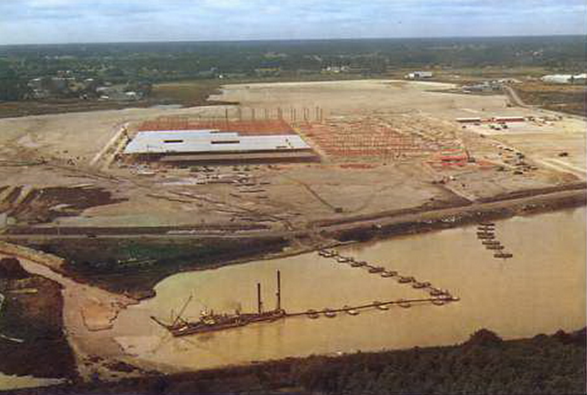
Blanquefort-FORD – La construction de l'usine est en cours et la zone à draguer se termine.
