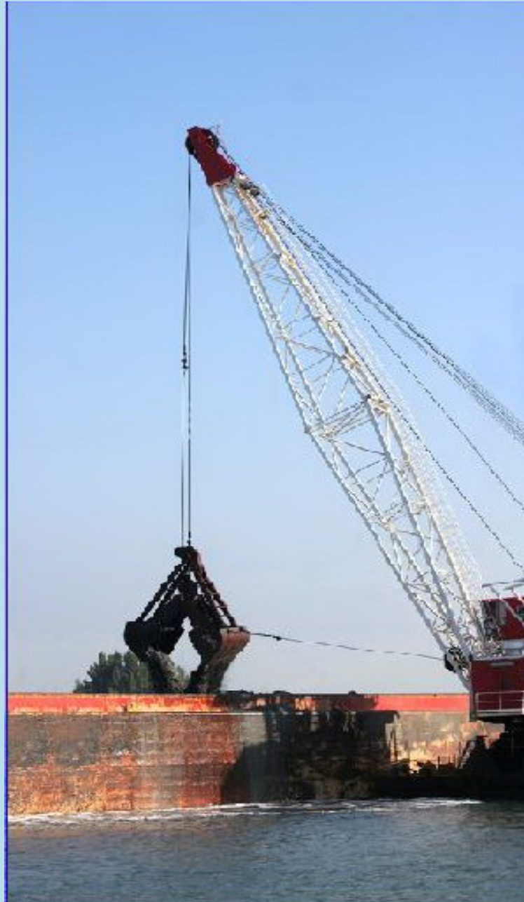
Remplissage du chaland par la drague à benne
