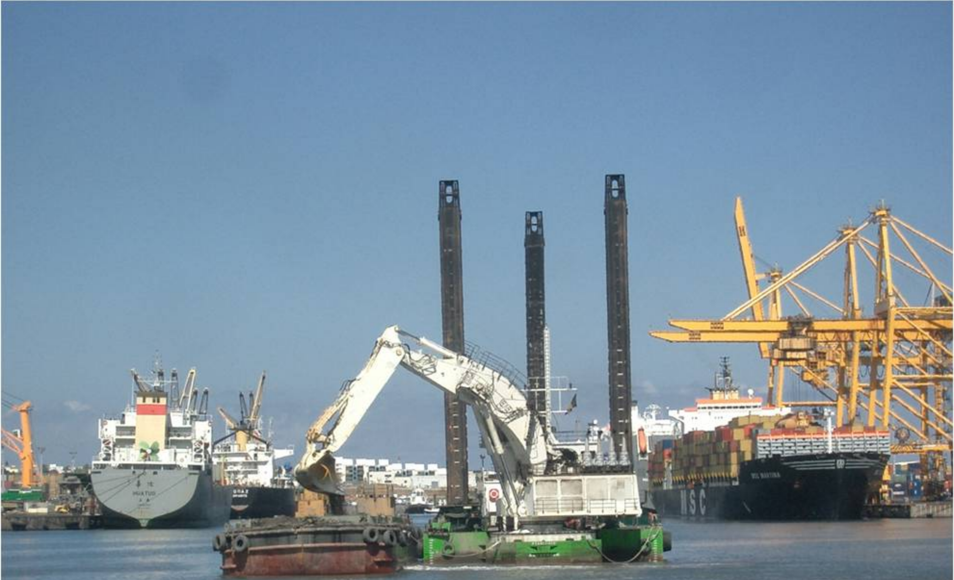
Grue de dragage hydraulique sur pieux avec godet
